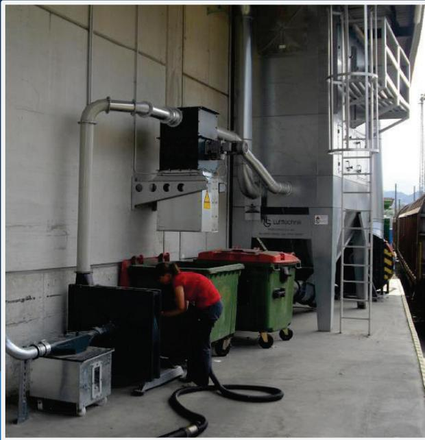
NG Hochdruckventilator 15kW
