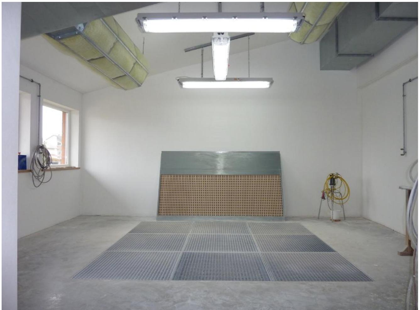
**Bild:** Kombination aus Bodenabsaugung und Wandabsauganlage
